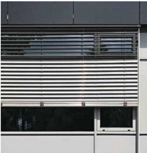
**Abb. 25** Fenster mit außenliegendem Sonnenschutz, der hinterlüftet werden kann.
